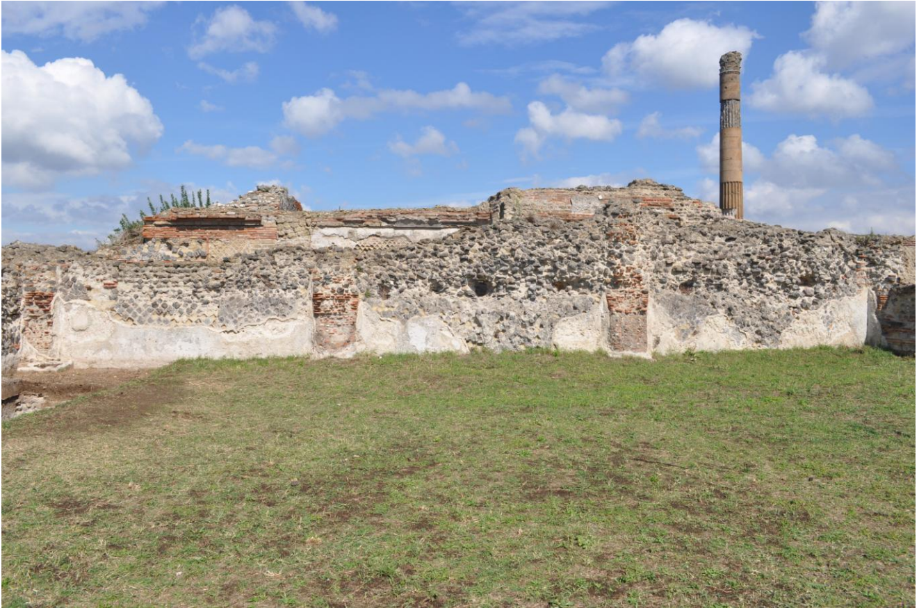
Fig. 4. Lato interno del muro nord della basilica (foto autore).
