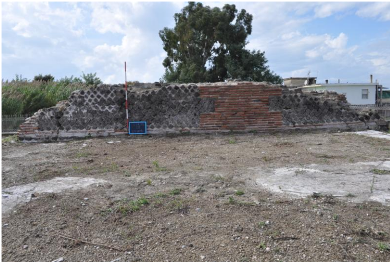
Fig. 18. Muro della struttura di sostegno delle statue di culto (foto autore).
