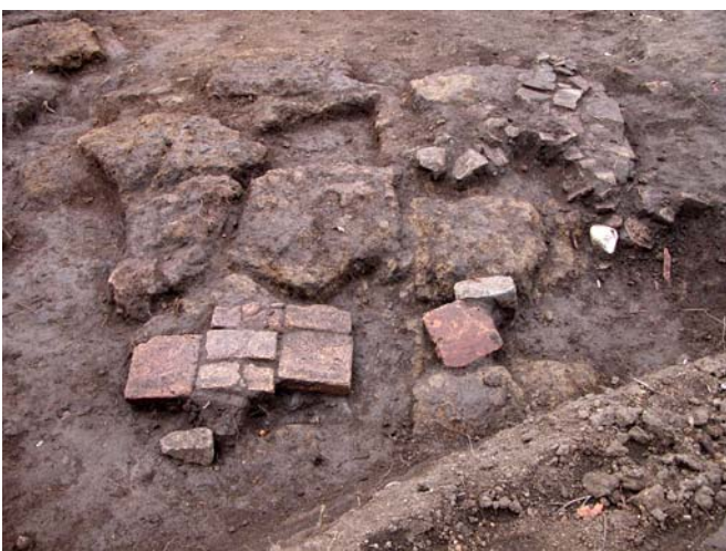
Fig. 10. Seconda fase costruttiva. In alto a destra resti di scapoli di tufo e basalto
