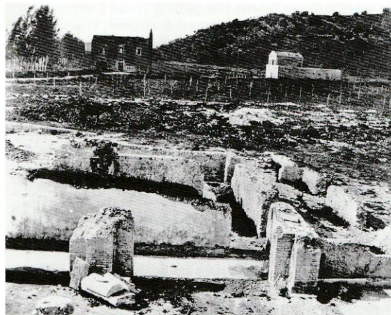
In primo piano il vestibolo colonnato 9, sullo sfondo la chiesa (a sinistra) e le terme (a destra)
