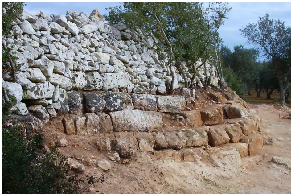
Fig. 2. Dettaglio del paramento riportato alla luce in occasione degli scavi del 2006.
