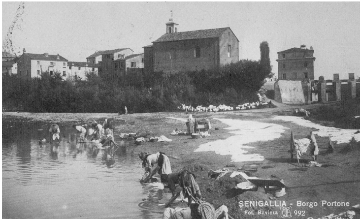
Fig. 40. La chiesa del Portone in un'immagine degli inizi del 1900. La Chiesa, in evidente rapporto col fiume Misa e con la “porta” che immette nel canale Penna, si trovava su un dosso rilevato.
