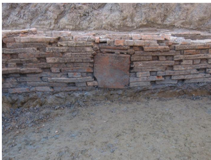
Fig. 16. Via Baroccio: particolare della chiusura con una tegola del lato verso l'interno del sacello (sud).
