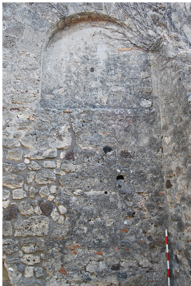
Fig. 44. Casa “di Arianna”. Arco cegado del ambiente 22 desde el exterior.
