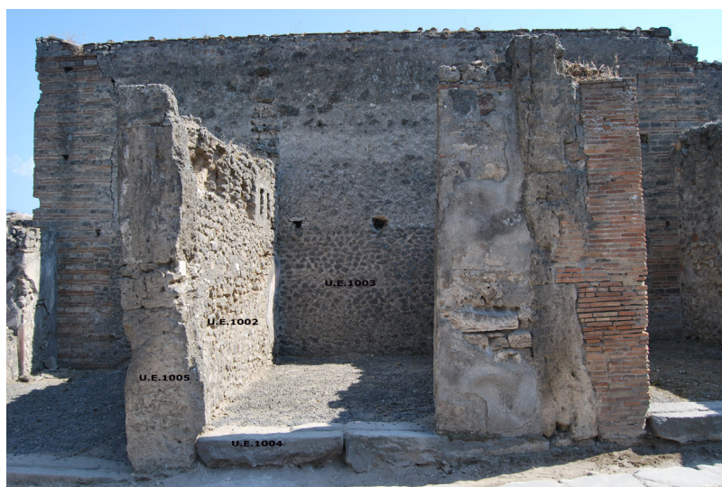
Fig. 10. Sondeo del macellum. Umbral (UE 1004), jamba (UE 1005), muro oriental de la taberna (UE 1002) y norte del macellum (UE 1003).
