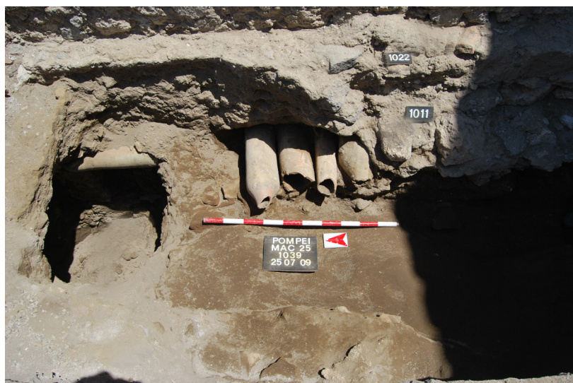
Fig. 15. Sondeo del macellum. Reparación de la cubierta con canal con ánforas.
