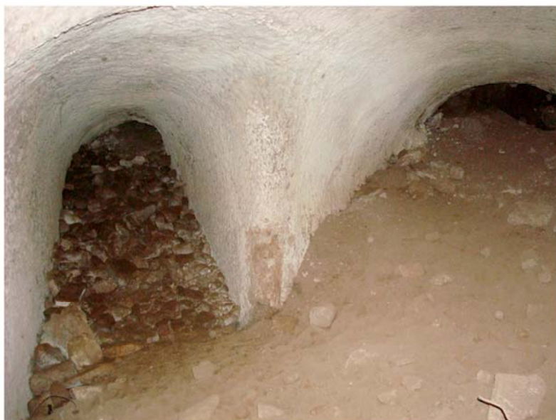
Fig. 13. La biforcazione a V della galleria C sotto il portico centrale dell'Accademia (foto di MARTA BOTTACCHI).
