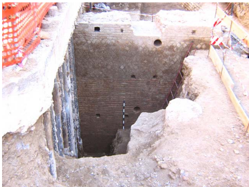
Fig. 20. Via Emanuele Filiberto - Stazione Manzoni, nuovo pozzo di ventilazione: muro monumentale in opera mista, foto lato sud (foto D. Colli).
