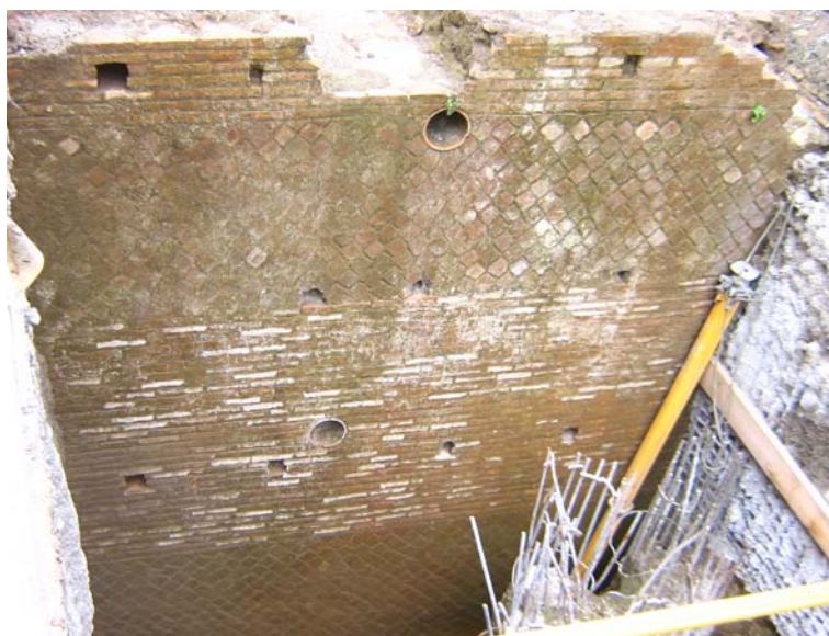
Fig. 8. Via Emanuele Filiberto - Stazione Manzoni, nuovo pozzo di ventilazione: tratto di muro perimetrale in opus mixtum dei Castra Priora Equitum Singularium (foto D. Colli).
