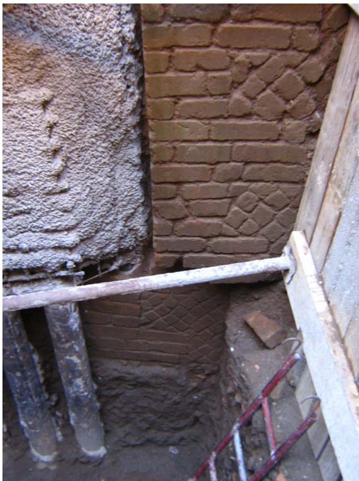
Fig. 24. Via Emanuele Filiberto - Stazione Manzoni, nuovo pozzo di ventilazione: i muri sovrapposti 45 e 61 (foto D. Colli).
