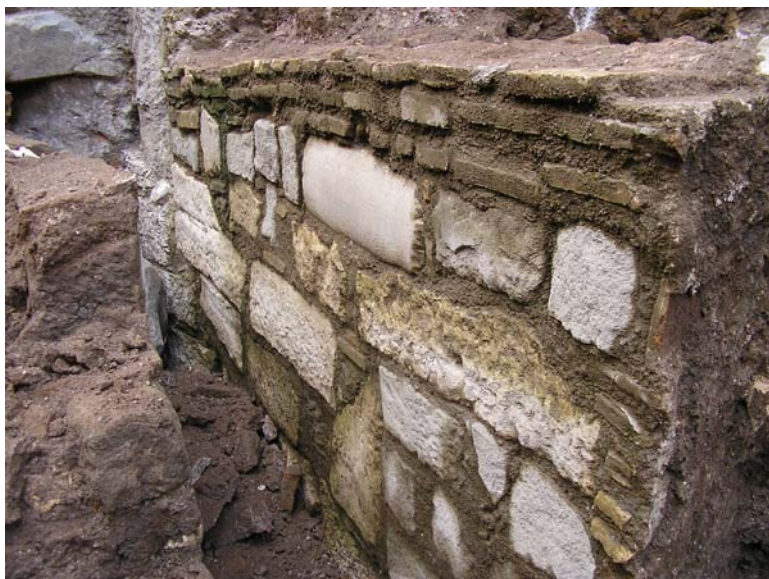
Fig. 38. Via Emanuele Filiberto. Pozzo M. Fogna 4, II fase, particolare della spalletta occidentale (foto di S. Palladino).
