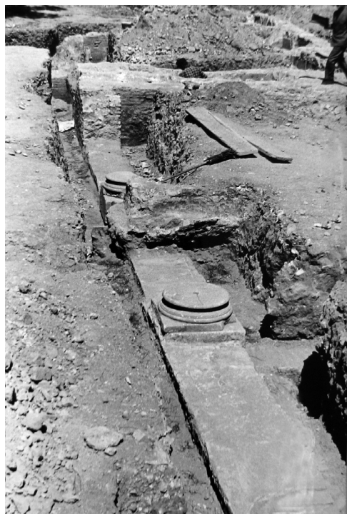
Fig. 32. Murature emerse nel corso degli scavi Colini 1953-7 e pertinenti ad un ambiente porticato (Archivio storico della Sovraintendenza del Comune di Roma inv. n. 13785).
