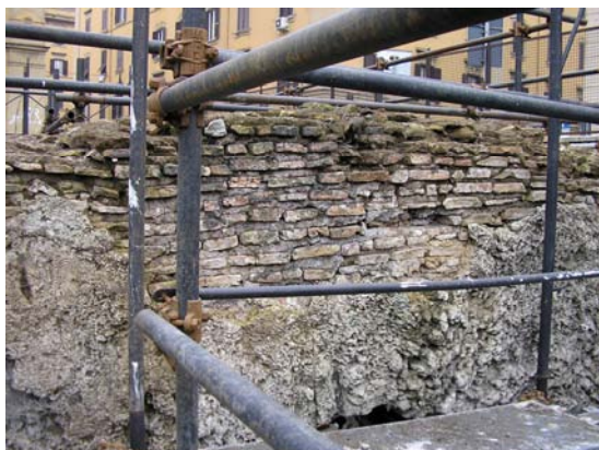
Fig. 22. Interventi antichi di ripristino delle murature, particolare (foto di S. Palladino).
