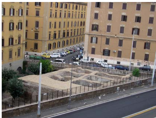
Fig. 23. La cisterna dell'acqua al termine delle operazioni di consolidamento e restauro, panoramica dall'alto (foto di S. Palladino).
