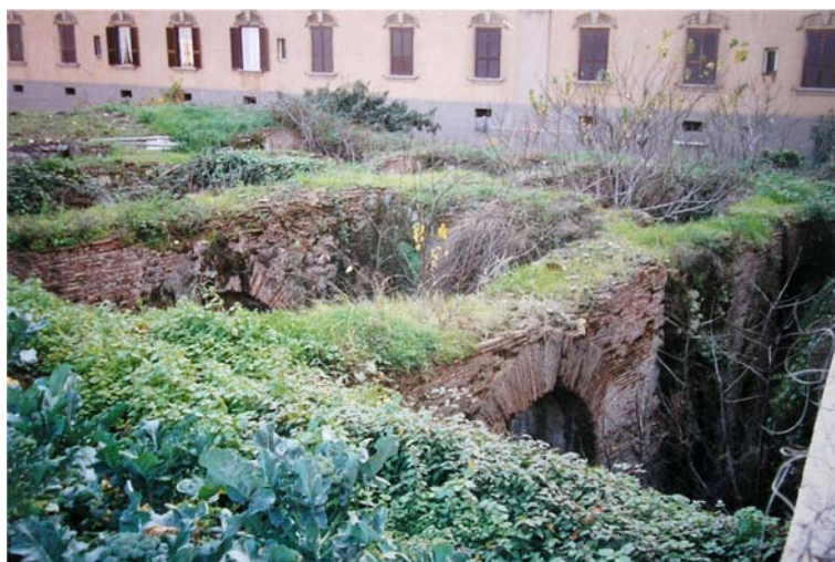
Fig. 15. La cisterna dell'acqua prima delle operazioni di restauro. Panoramica dall'alto (foto di S. Palladino).
