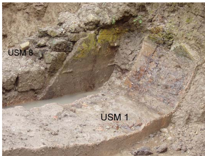
Fig. 2. USM 1 - struttura muraria compromessa dalla massiccia presenza di acqua e USM 8 - struttura muraria in blocchi di tufi di reimpiego (foto SSBAR, op. E.R.).
