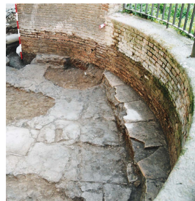
Fig. 21. Nicchia 4. Risega di fondazione con piano in mattoni.
