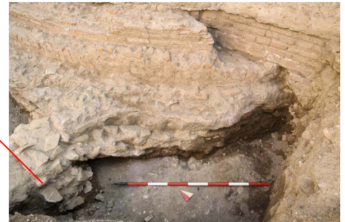
Fig. 17. Esterno della nicchia 5. Crollo del muro (USM 47).
