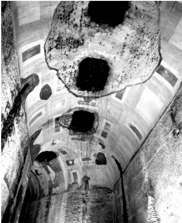
Fig. 3. Villa Adriana, Serapeo. Stato degli affreschi prima del distacco: settore centrale della volta vista dal fondo.
