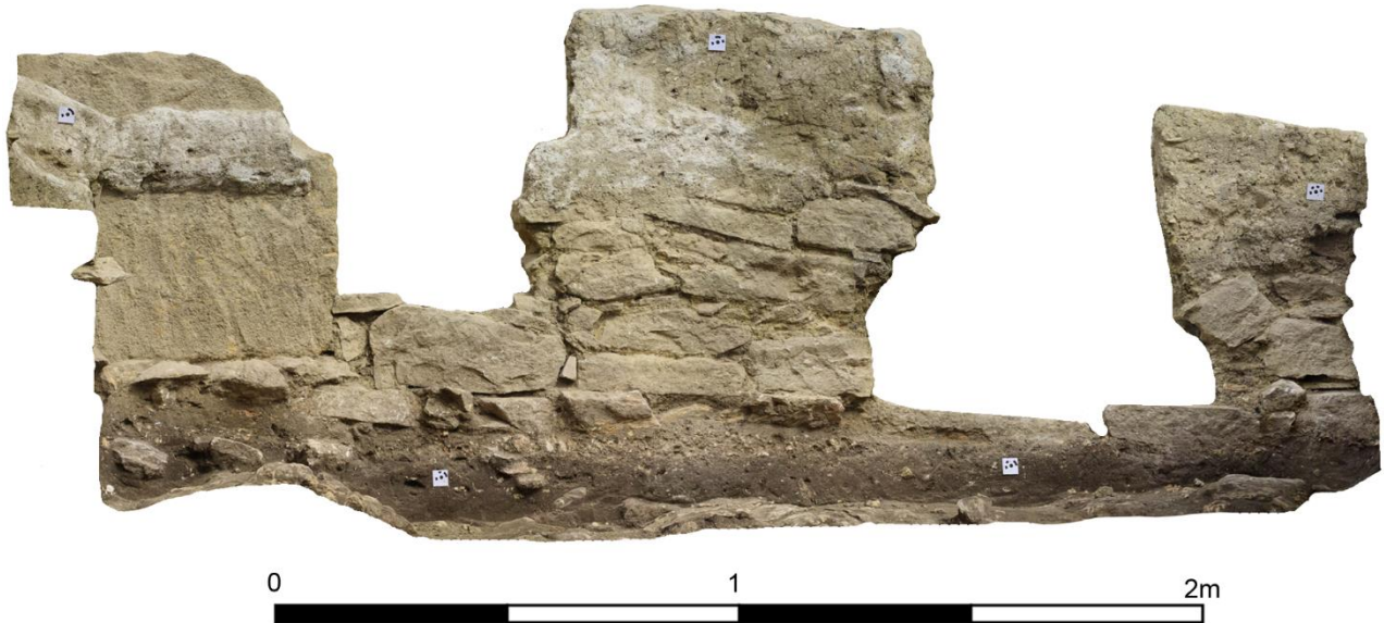
Fig. 16: Muro con base di pietre ed elevato in mattoni d'argilla [41]. Sulla facciata orientale si vedono i residui di un intonaco con calce (@DAI-Rom, M. Jonasch)
