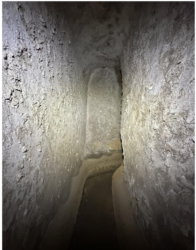
Fig. 16. Svolta del canale, con abbandono e tompagnatura dello scavo in direzione rettilinea.
