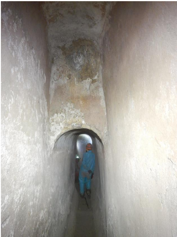
Fig. 15. Variazione di livello della volta dello speco, fra gli spiragli L1 e L2.
