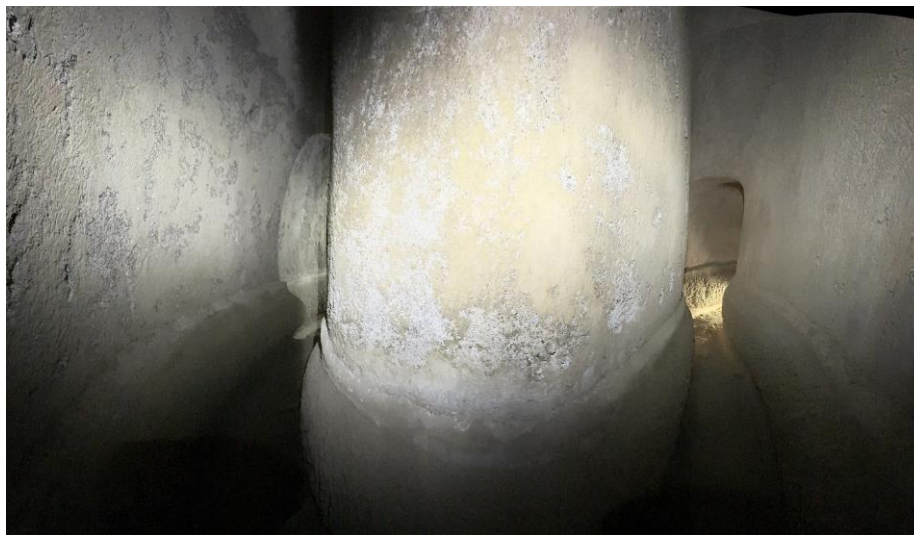
Fig. 13. Curva stretta nel tratto di canale compreso tra gli spiragli R7 e R8.
