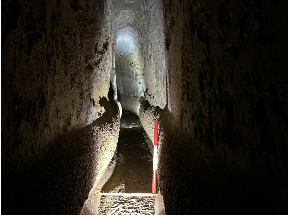
Fig. 8. Tratto rettilineo di condotto ben conservato, con rivestimento idraulico e deposito calcareo alla base.
