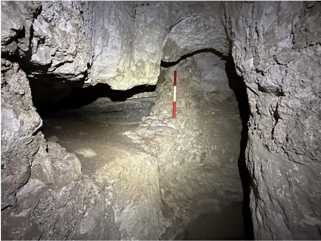
Fig. 14. Tratto in prossimità dello spiraglio R1, dove la presenza di una bancata di materiale piroclastico poco coerente ha richiesto la posa di sezioni di muratura di contenimento.
