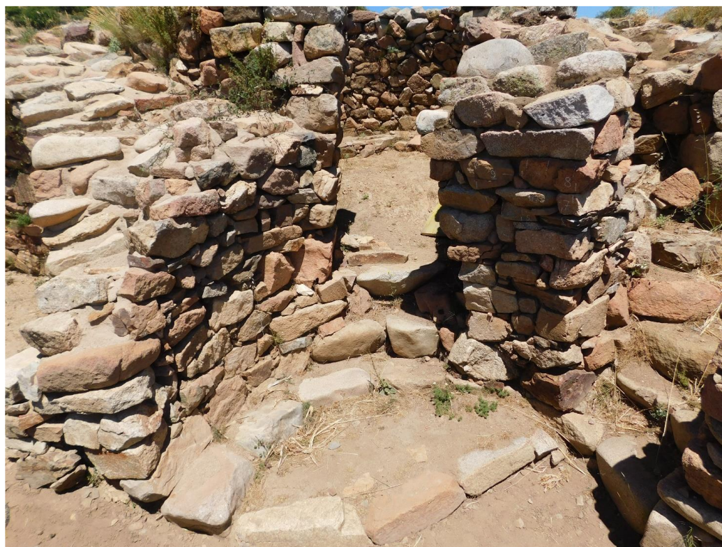
Fig. 5. Villagrande Strisaili, S'Arcu 'e is Forros: ingresso al vano 2, al vano 4 e scala: i filari di base evidenziano una unitarietà costruttiva.
