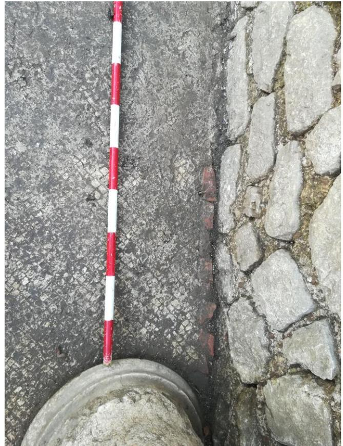
Fig. 6. Cordolo di collegamento del pavimento musivo alle strutture murarie.
