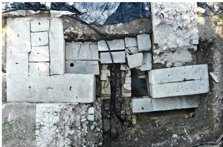
Fig. 6. Aquileia, teatro romano: immagine zenitale delle strutture murarie e dei condotti ipogei all'entrata dell' aditus maximus settentrionale. In basso il poderoso muro 6017, in appoggio alla fronte esterna del pilastro orientale.
