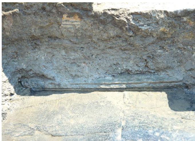
Fig. 12. Aquileia, teatro romano: la frons pulpiti più tarda, costruita al di sopra dello zoccolo in marmo appartenente a quella più antica. In primo piano, le lastre originarie di pavimentazione dell'orchestra. Si notino le alterazioni dovute all'acqua di falda.
