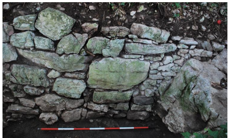
Fig. 21. Particolare della struttura di terrazzamento di Area 4000 realizzata in epoca preromana.
