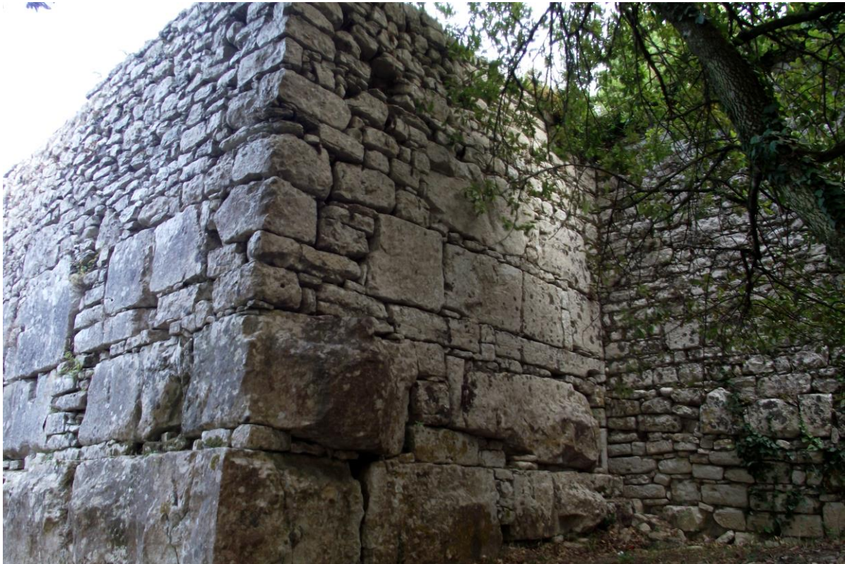
Fig. 19. Torre 3, lato sud. Zoccolo e alzato di prima fase (DE VINCENZO 2016, 43, fig. 7).
