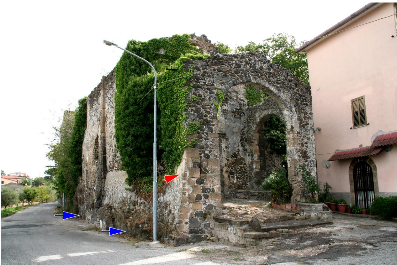
Fig. 2. La Chiesa di S. Bartolomeo Apostolo vista da Nord-Ovest (la freccetta rossa indica la posizione in cui è murata l'epigrafe; le frecce azzurre indicano la posizione del basamento in opera poligonale).
