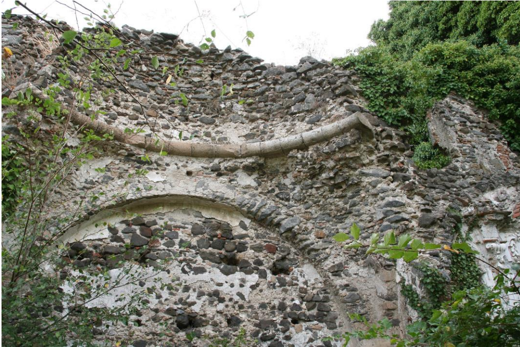
Fig. 13. Particolare dell'attacco del catino absidale della navata della Chiesa di S. Bartolomeo in Sipicciano con il toro in materiale lavico.
