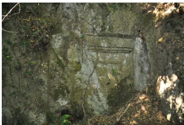
Fig. 4. San Simone, collina sud, pendice settentrionale. Facciata di tomba a finto dado con cornice a becco di civetta.
