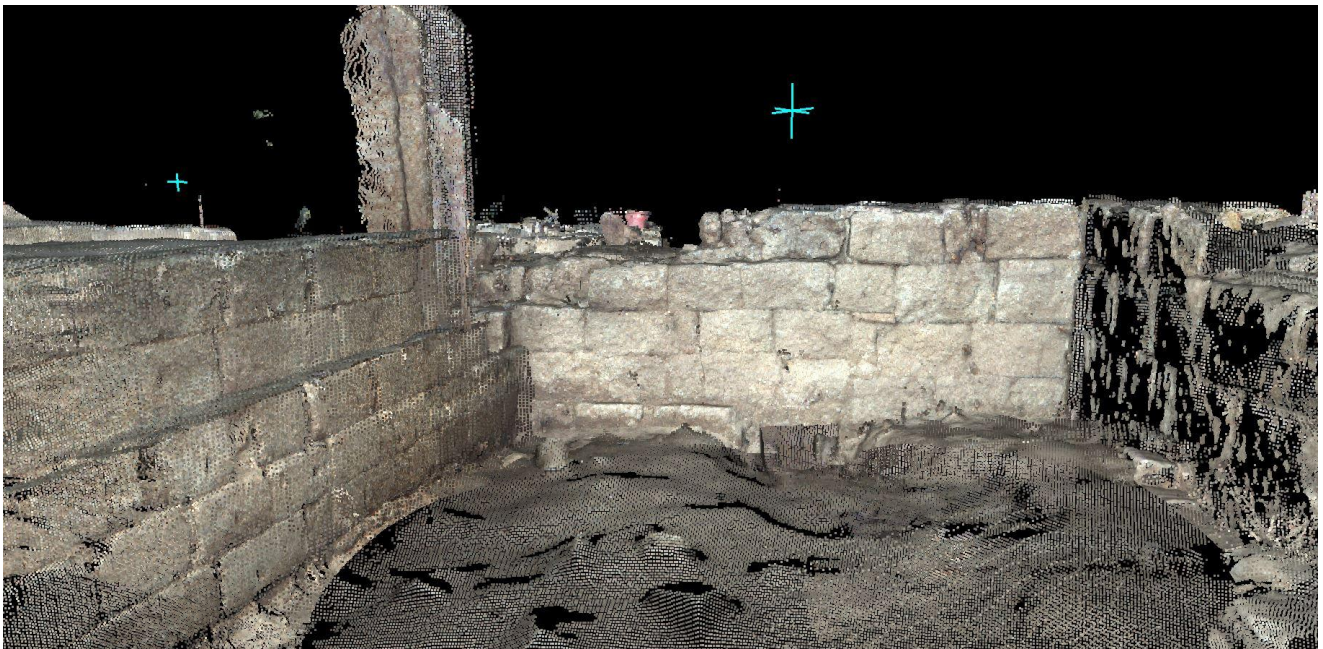
Fig. 13. Ambiente 2. Rilievo laser scanner delle strutture murarie.
