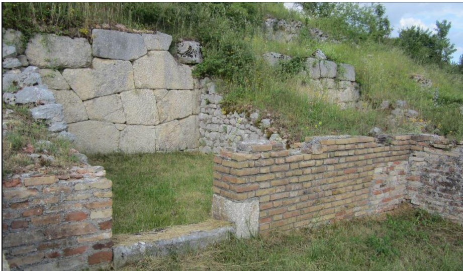
Fig. 15. Tabernae su via dei Pilastrì: il muro di terrazzamento in opera poligonale e le strutture addossate.
