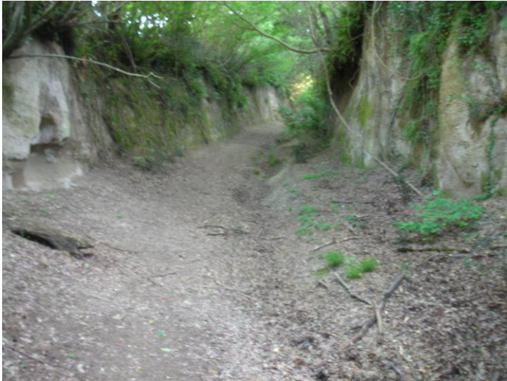
Fig. 6. Tagliata stradale che fiancheggia la Chiusa del Belli e raggiunge il torrente Olpeta presso la loc. S. Maria di Sala.
