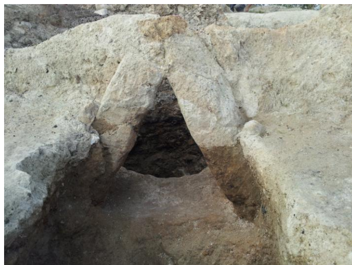
Fig. 3. Loc. S. Marta (Capena), fornace n. 4, particolare dell'imboccatura del praefurnium costituita da due blocchi di tufo che formano un'apertura triangolare.
