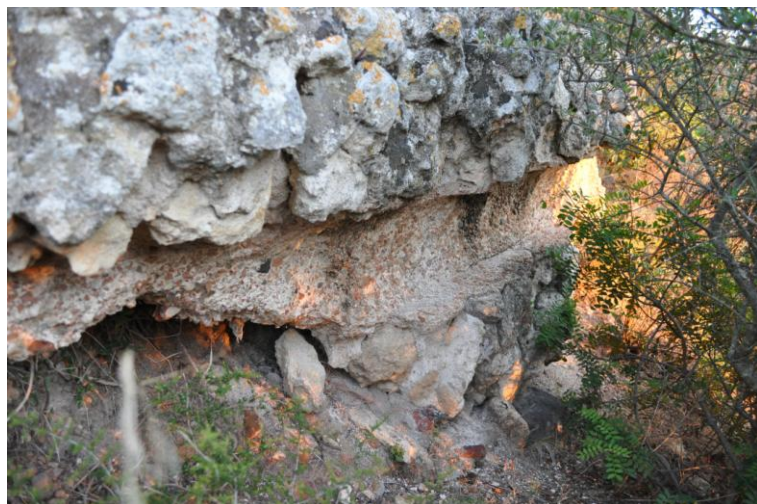
Fig. 3. Resti dell'acquedotto nel settore est di Corchinas (foto dell'autore).
