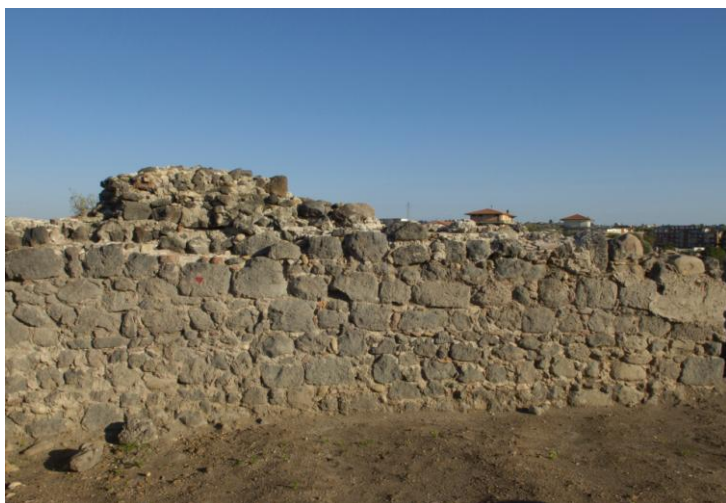
Fig. 33. Il paramento murario esterno della navata settentrionale (foto G. Barbagiovanni).
