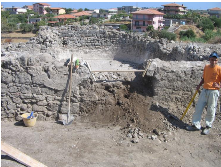
Fig. 44. Fase di smontaggio del muro di tompagno posto a chiusura dell'ingresso centrale alla Basilica (foto E. Bonacini).
