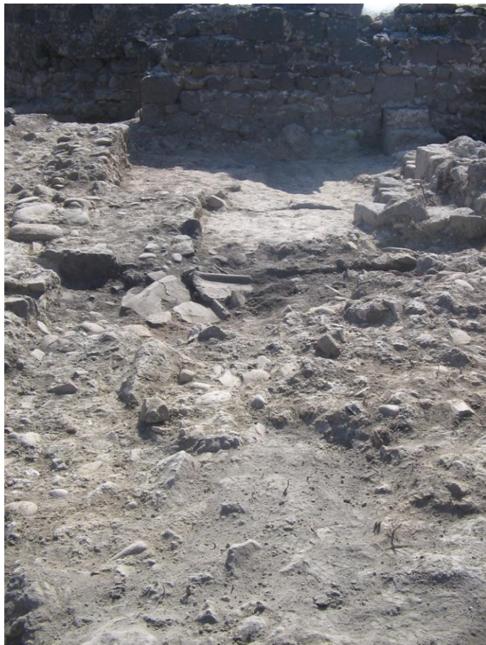
Fig. 22. Il crollo 75 nel Vano G (foto E. Bonacini).
