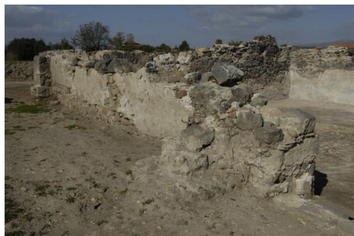
Fig. 37. Il pilastro inglobato nel muro di chiusura della II fase (foto G. Barbagiovanni).
