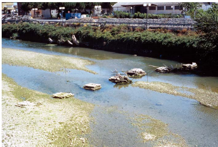
Fig. 1. Albenga. Alveo del Centa. Pile dell'acquedotto romano.
