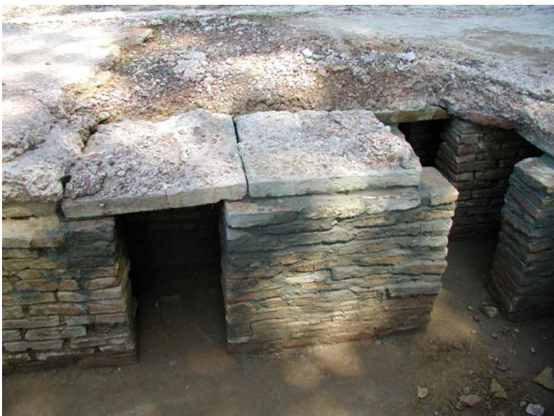
Fig. 4. Dettaglio delle pilae dell'ipocausto.
