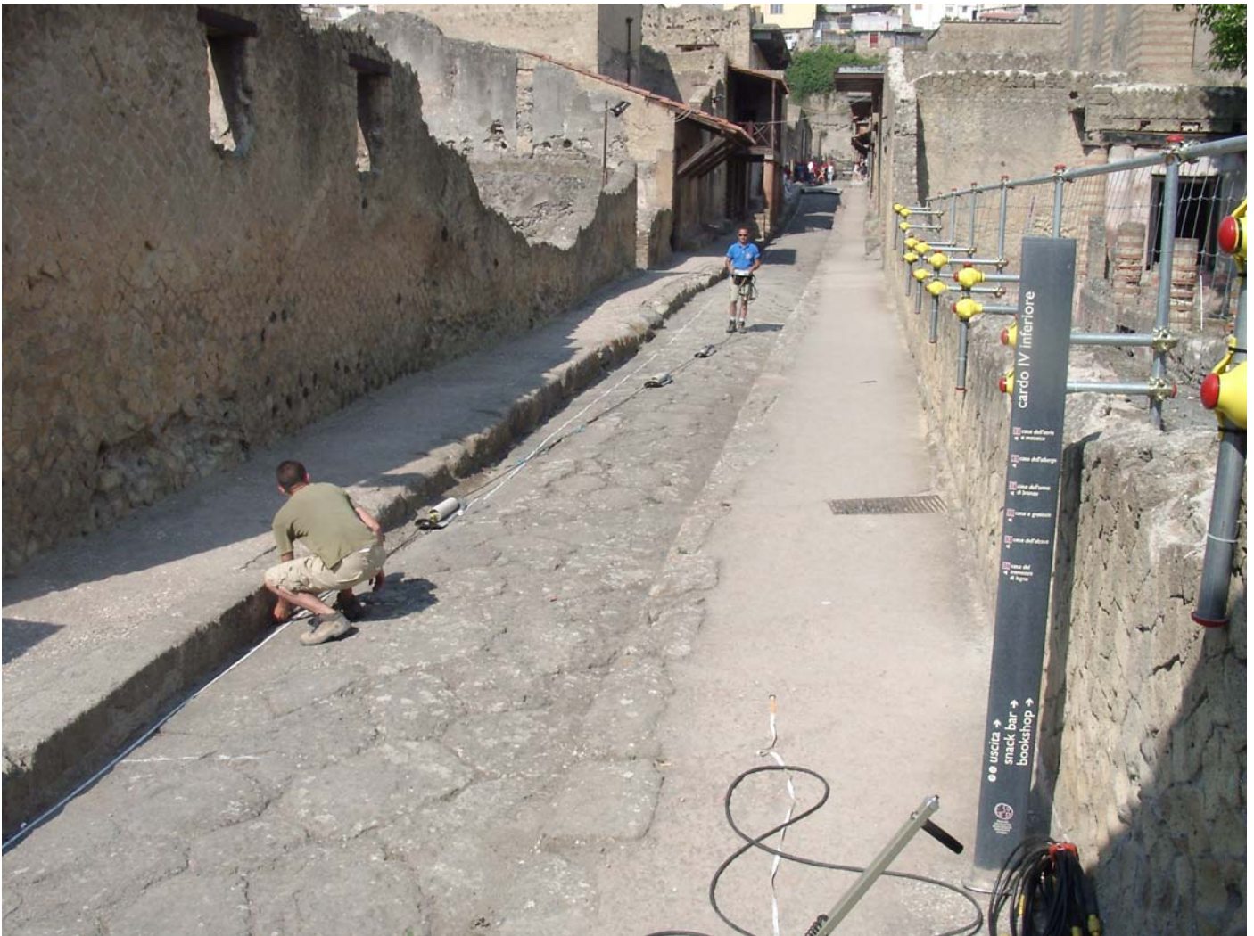
Fig. 22. La realizzazione delle indagini geoelettriche lungo il cardo IV.
