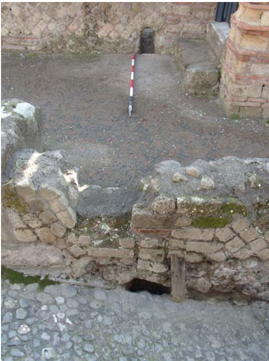
Fig. 21. Il foro di scarico della latrina che confluisce in una canaletta collegata alla fognatura del cardo IV.
